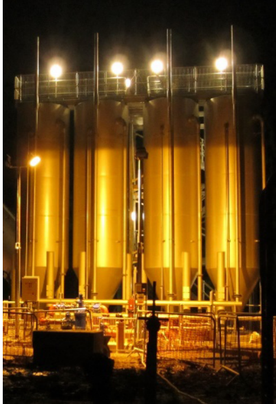
FIGUUR 1.2.1 NAGESCHAKELDE BIOLOGISCHE CONTINUFILTRATIE - WWTW HOLBEACH, ANGLIAN WATER
