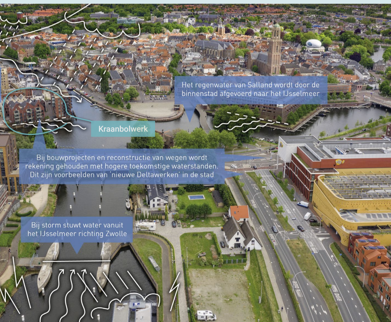
Nieuwbouw Kraanbolwerk houdt rekening met kans op overstrooming vanuit verschillende kanten.
